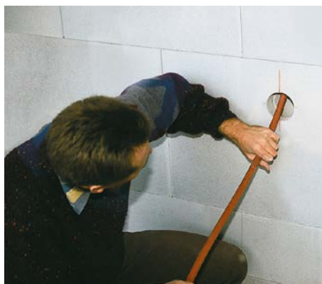
Bild 6 Einziehen eines Leerrohres
