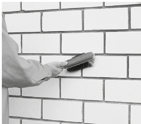
Bild 31 Eventuell vorhandene Mörtelreste sind abzufegen.
