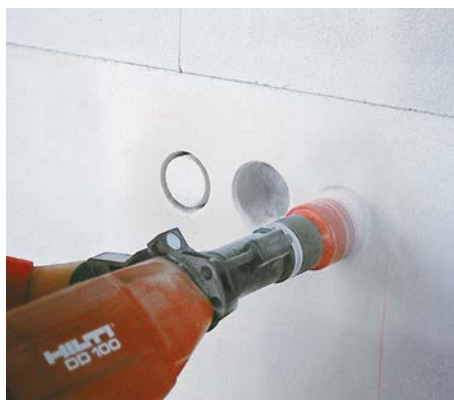
Bild 5 Fräsen von Öffnungen für Schaltdosen
