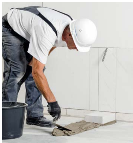
Bild 6 Mörtel auf die Betonsohle auftragen
