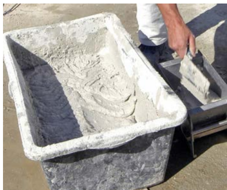
Bild 5 Der Dünnett Mörtel wird in den Mörtelschlitten eingefüllt.
