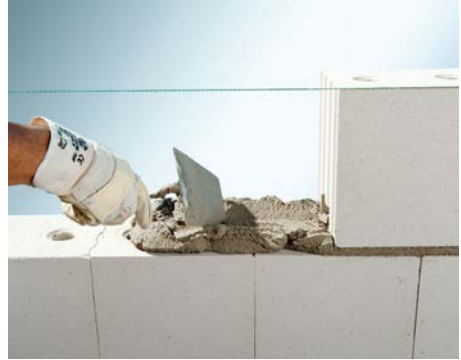
Bild 4 Verarbeitung von Normalmauermörtel
