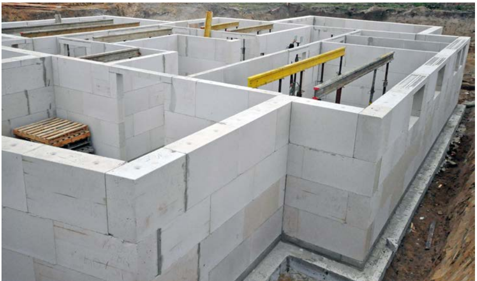
Bild 5 Keller, aus KS XL-Elementen erstellt
