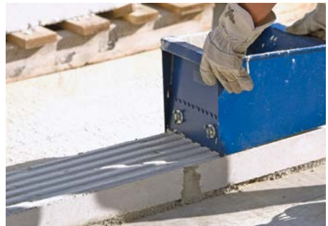
Bild 3 Der Dünnbettmörtel wird mit dem Mörtelschlitten und der vom Dünnbettmörtel-Hersteller empfohlenen Zahnschiene aufgetragen.
