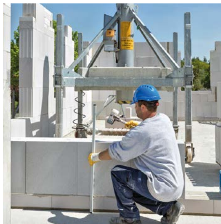
Bild 13 Eine gute Baustellenorganisation ermöglicht durchgängiges Arbeiten.
