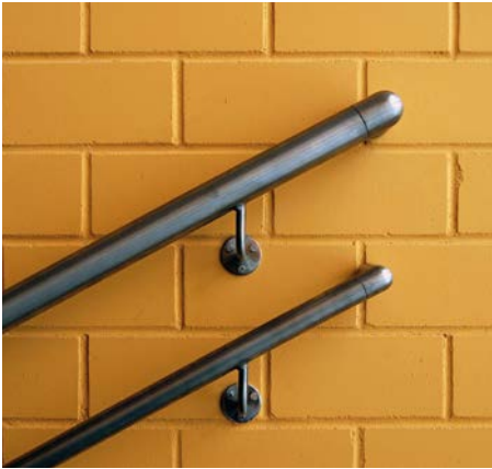
Bild 10 Befestigung von Treppengeländern an KS-Mauerwerk
