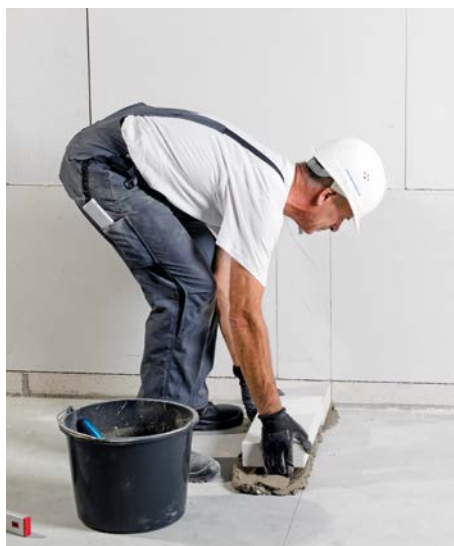
Bild 8 Kimmsteine ins Mörtelbett verlegen
