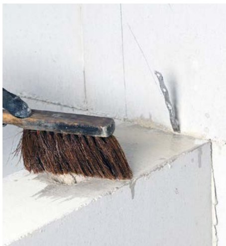
Bild 6 Bei hohen Außentemperaturen sind die Steine vorzunässen.
