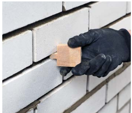
Bild 29 Auskratzen der Fugen mit einem Holzbrettchen
