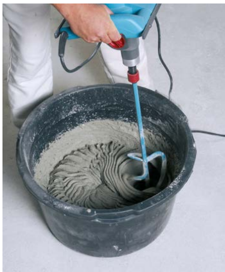
Bild 14 Der Mörtel wird nach Verarbeitungsanweisung gleichmäßig durchgemischt.
