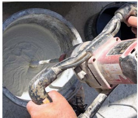
Bild 1 Anmischen von Dünnbettmörtel
