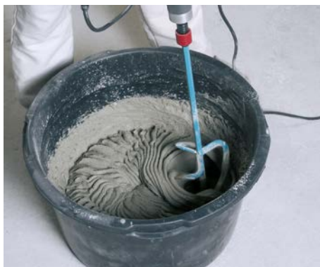
Bild 4 Der Dünnett Mörtel wird nach Herstellerangaben angemischt und nach vorgegebener „Reifezeit“ weiterverarbeitet.
